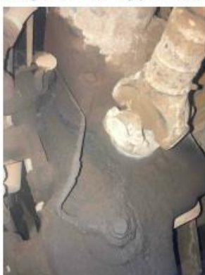
Image Comment(s):Leve humedad por fitting .
