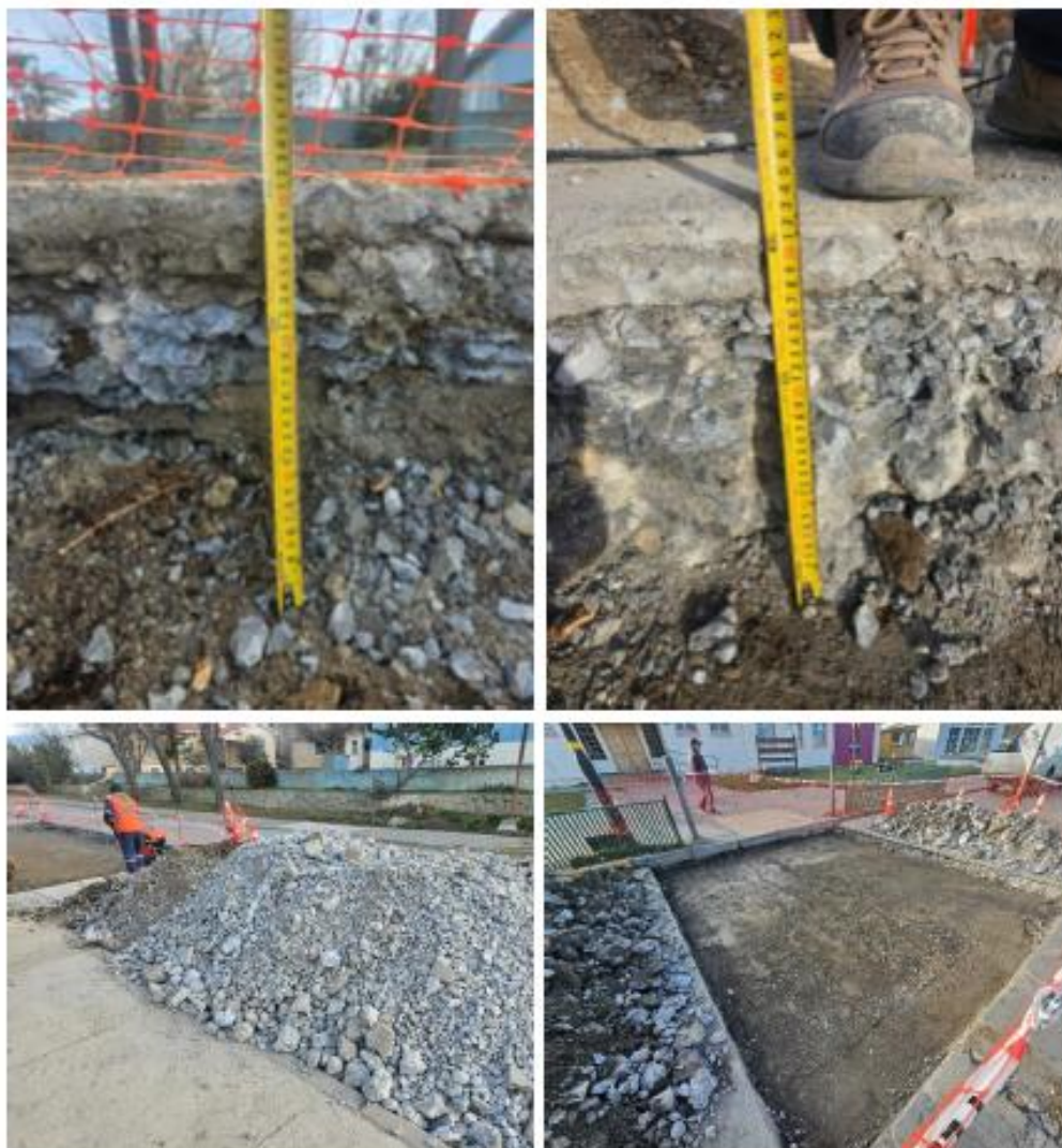
Imagen profundidad de excavación de los tramos de calzada en los dos sectores de calle Bernardo O'Higgins
