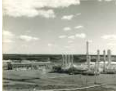
Vista panorámica Planta Gasolina Cullen.
