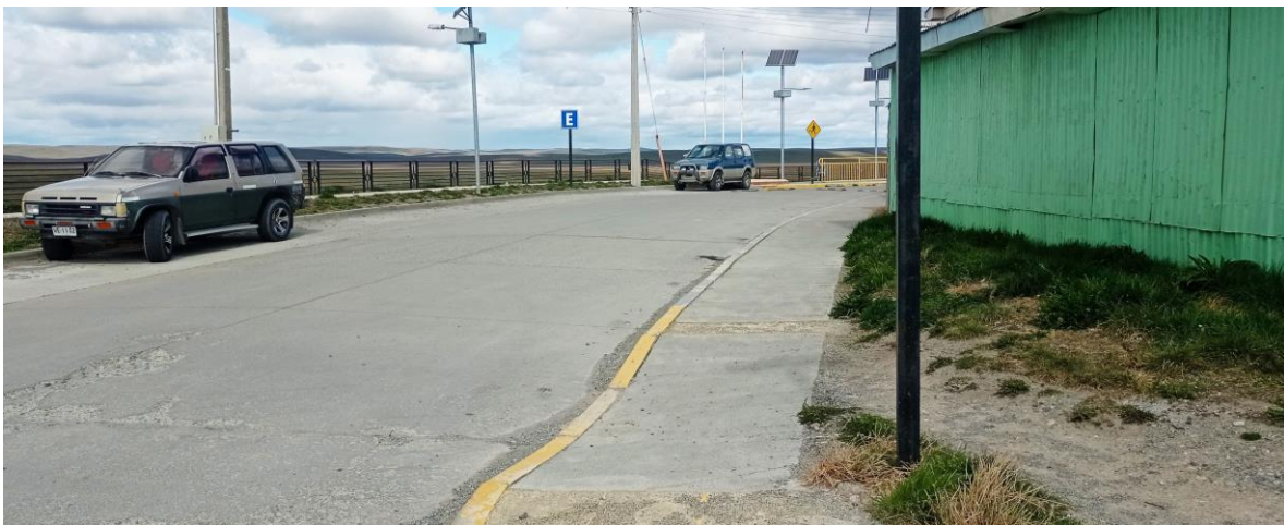
Calle Jorge Cárdenas, no se observa reposición de baldosas podotáctiles.
