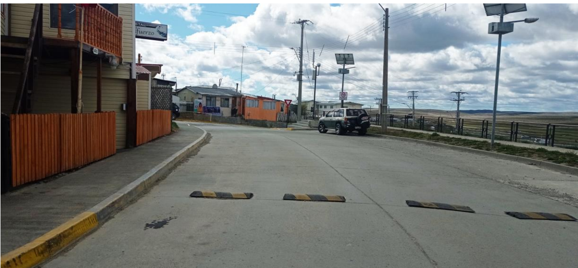
No se observa el mejoramiento de las pinturas de soleras en Calle Jorge Cárdenas
