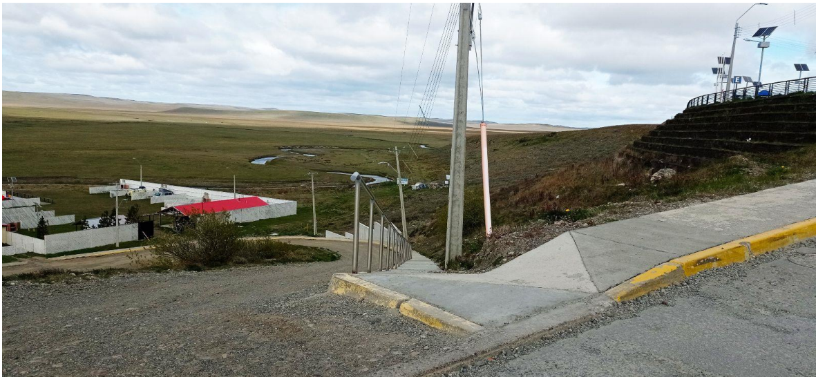
Vista general de la obra desde Calle Juan Fierro, hasta Mauricio Rivera.
