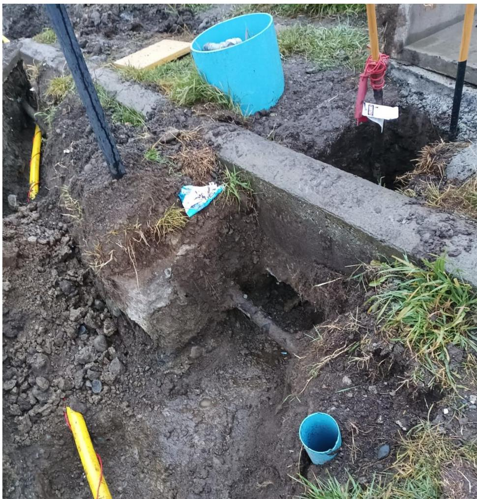
Imagen donde se identifica a la izquierda la nueva red de PEMD y a su derecha la antigua cañería de gas que abastece a la Sede Comunitaria, fotografía tomada el 26 de febrero, donde aun no se lleva a cabo la partida de conectar los arranques desde la línea nueva.
