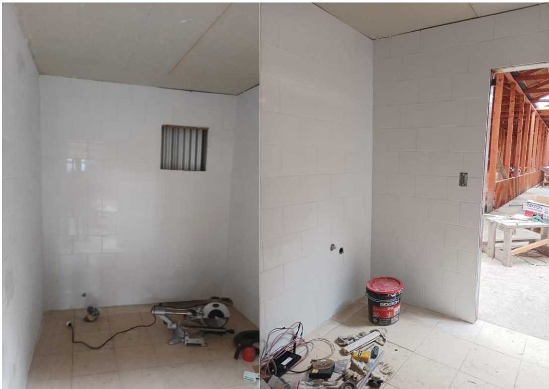
Baños sin la ejecución de las ventanas, pintura de cielo, los artefactos sanitarios, eléctricos y terminaciones lineales.
