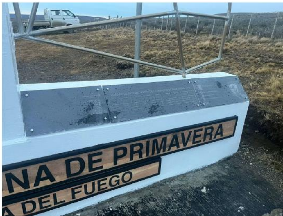
Fotografía 2: Acrílicos con placa de alucobond negro instalado. Hito Onaissin.
