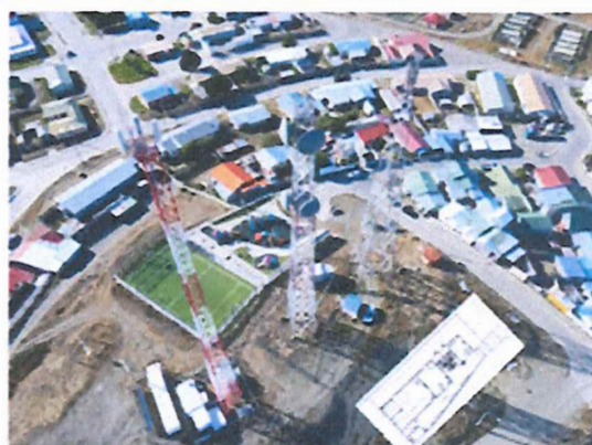
Fotografía N° 30 (plano y lugar físico donde se está construyendo centro integral de atención)
