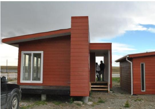
El proyecto contempló la construcción de una vivienda de 84,88 m<sup>2</sup> aprox., la cual consta de una sala estar, comedor y cocina integrados en un ambiente de 25,5 m<sup>2</sup>, baño de 3,25 m<sup>2</sup>, 2 dormitorios de 9,12 m<sup>2</sup> cada uno y un tercer dormitorio de 12 m<sup>2</sup>. El inmueble incorporó materialidades innovadores tales como placas de fibrocemento en el exterior, cubierta de zinc-alum pre pintadas y en su interior
