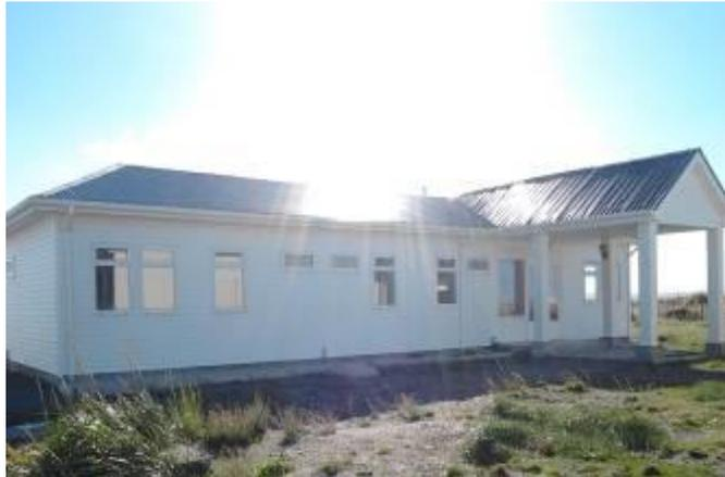
zinc-alum en cubierta de techumbre y tinglado de fibrocemento en muros, e interiormente con vulcanita y cerámicos de piso y muros, además se consideró como revestimiento de pisos de algunos recintos piso flotante.
